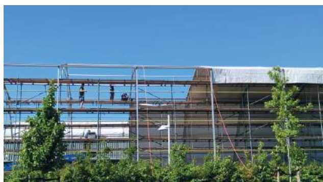
Het trekken van de zeilen
