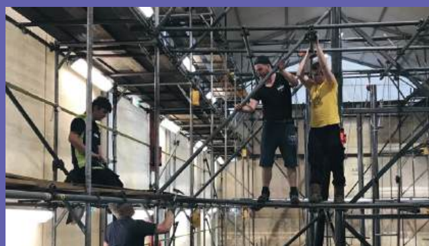
Steigers worden gemaakt zodat we overal bij kunnen
