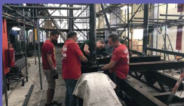
De constructie van de wagen wordt geplaatst
